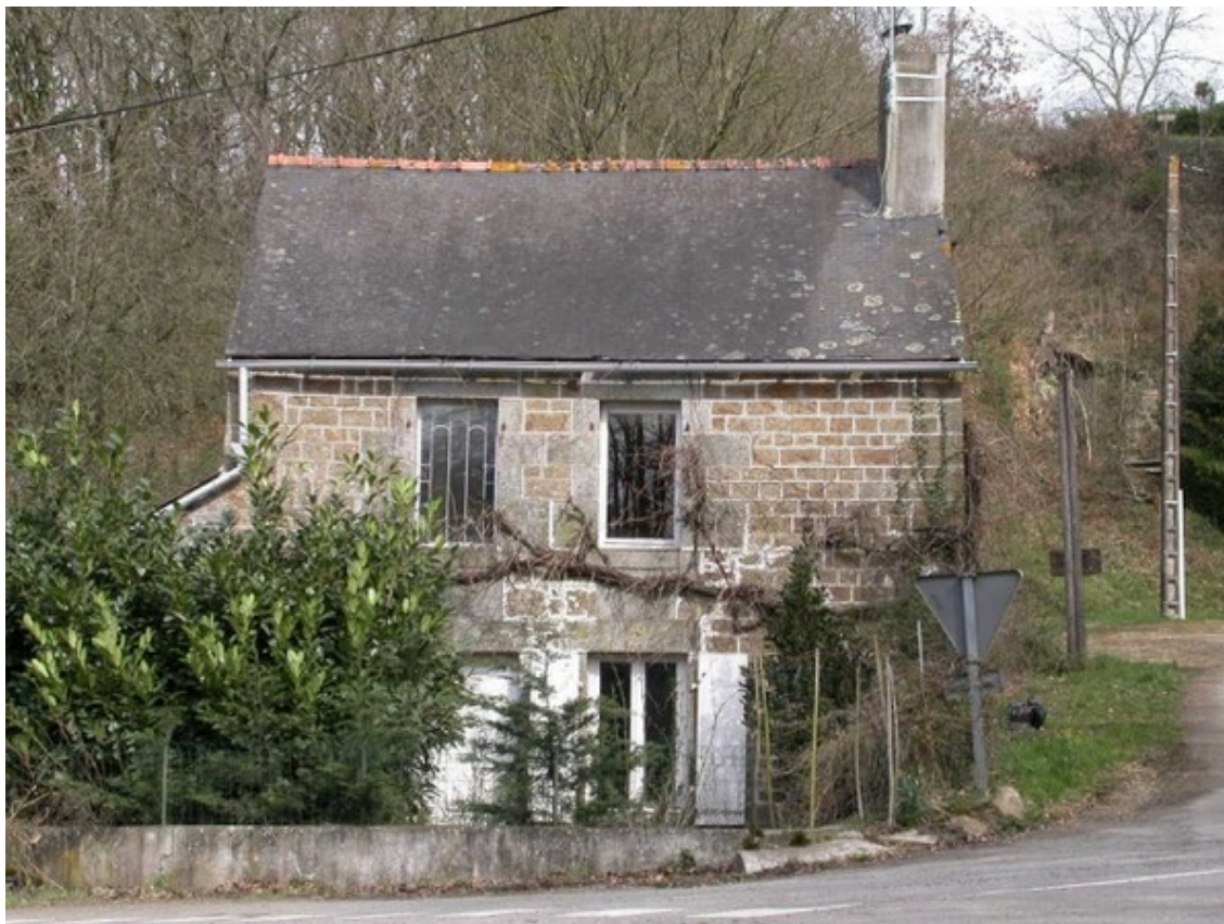
Façade Ouest sur route.
