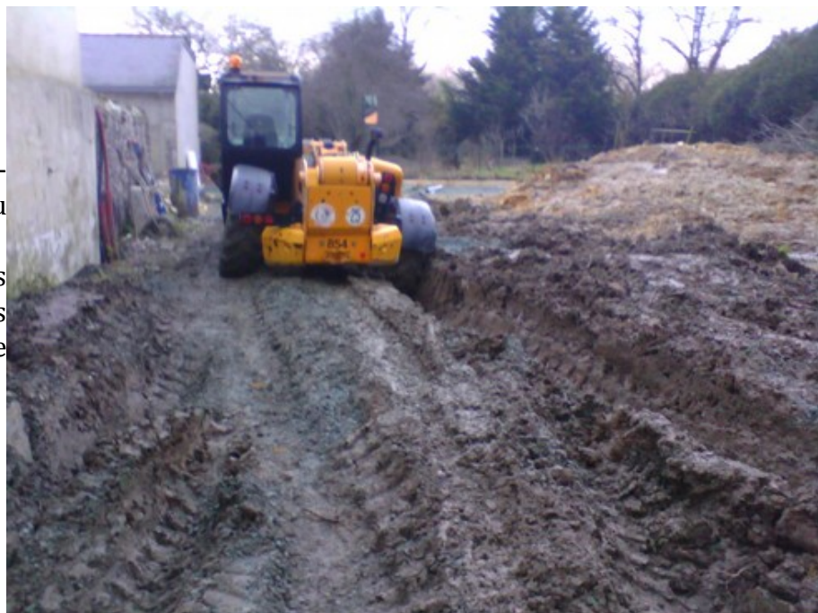
Fond de fouille après pompage de l'eau et terre plein avant dallage.
