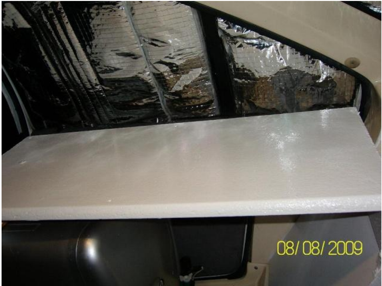
Photos du montage de la bassine
