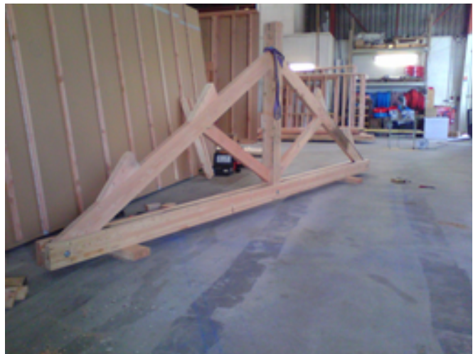
Fermettes fabriquées en petites séries en atelier, avant transport et pose sur une extension ossature bois.
