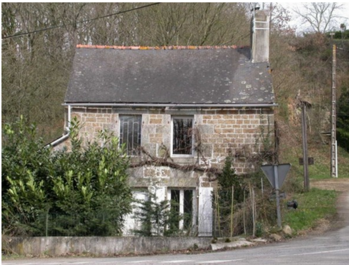
Façade Ouest sur route
