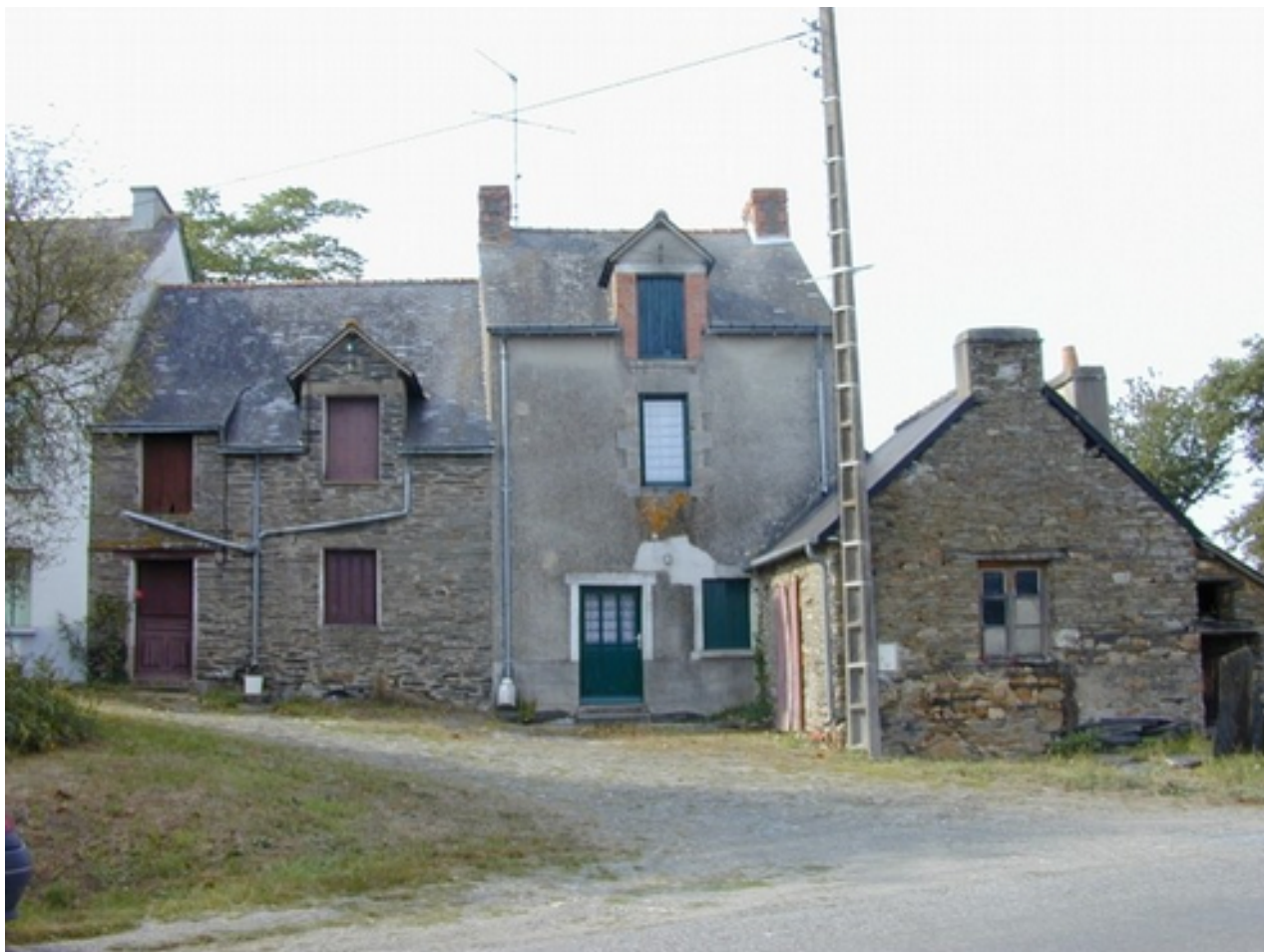
Façade Est : maison de gauche et ses extensions en bout d'alignement.
